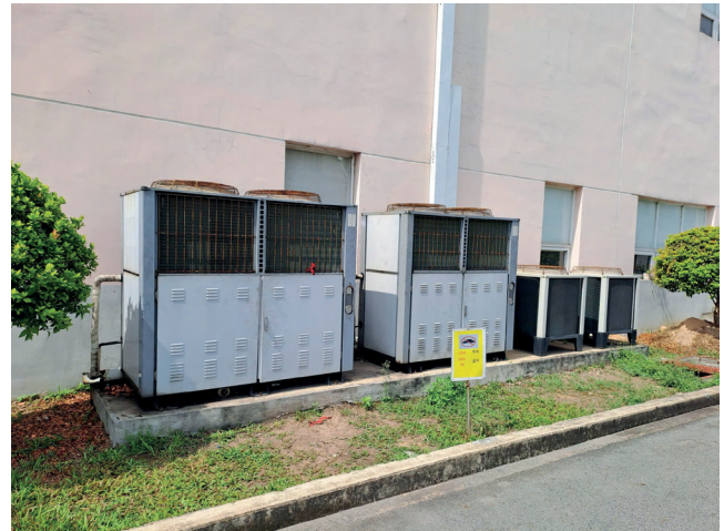
Nhà máy thực hiện giải pháp đề xuất từ VNCPD
